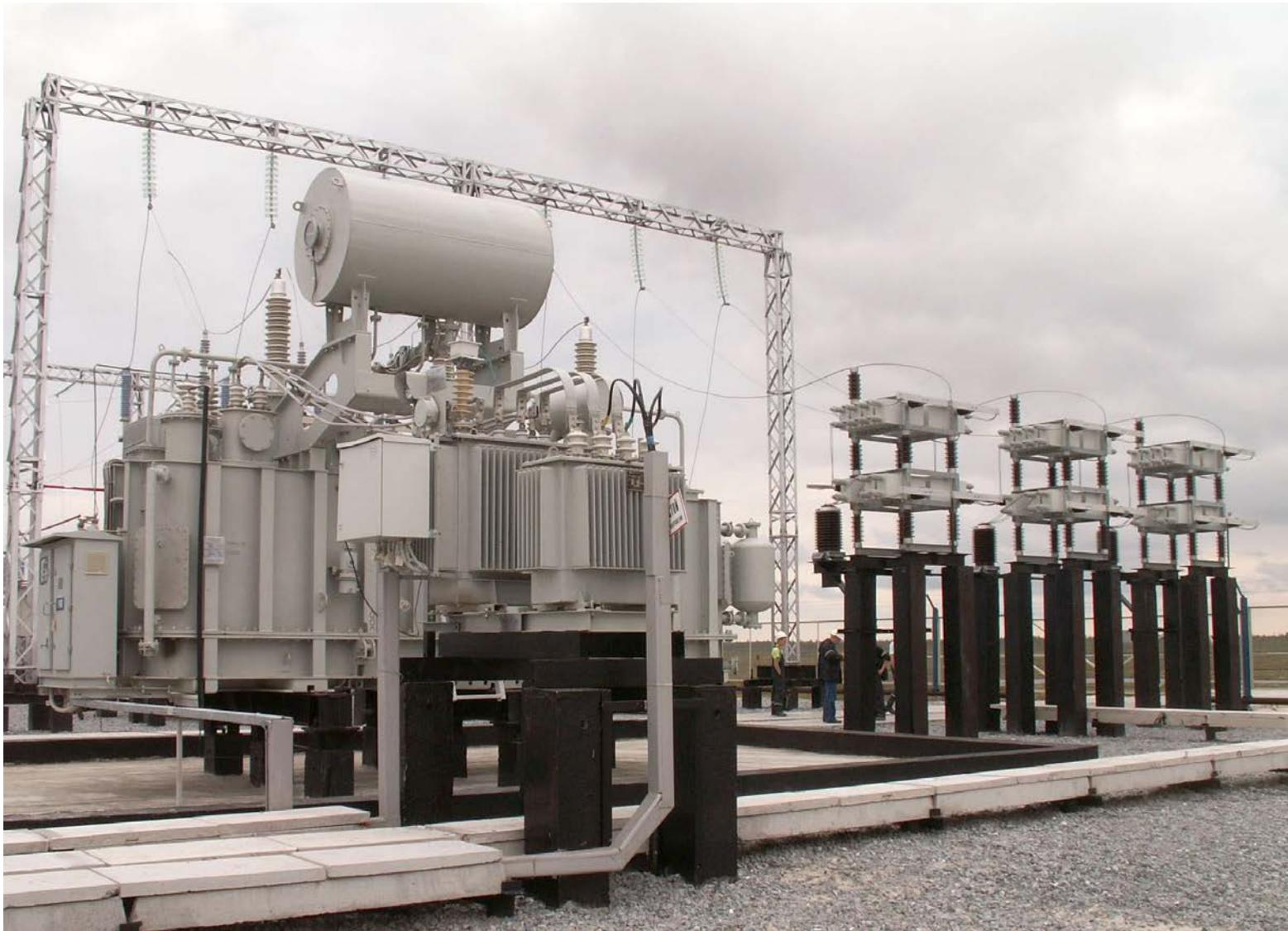
*Sistema CSR -25..+50 Mvar 110 kV para Noyabrskenergoneft SS «Sugmutskaya-2» (Rússia)*
