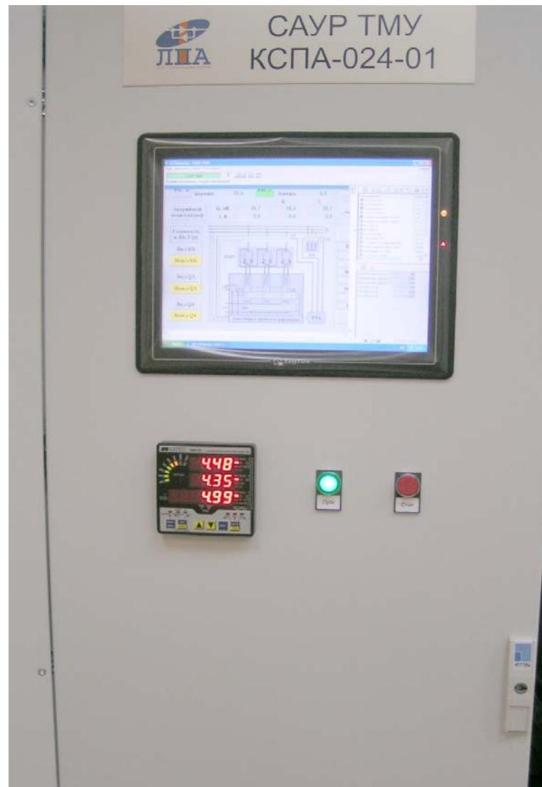
*Painel frontal do sistema de controlo automático SCSR -25..+25 Mvar 35 kV para Vankorneft SS «Vankor» (Rússia)*
