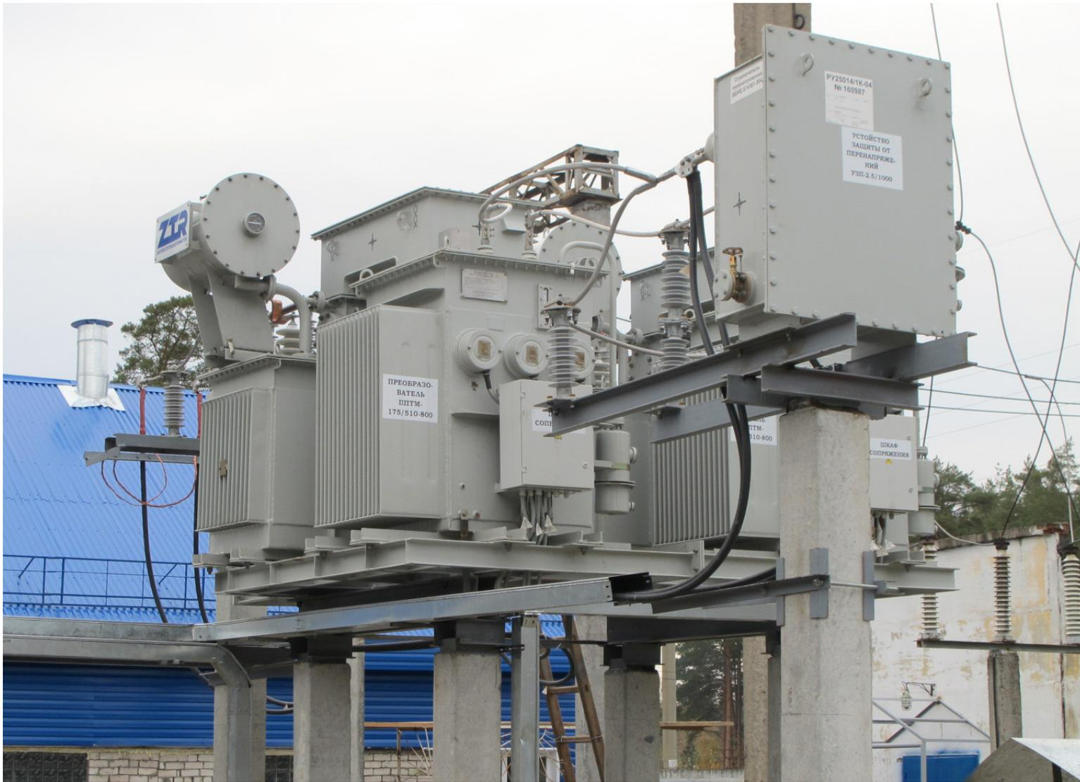
*Sistema de magnetização do SCSR -25..+25 Mvar 110 kV para MRSK Holding SS «Pokrov» (Rússia)*
