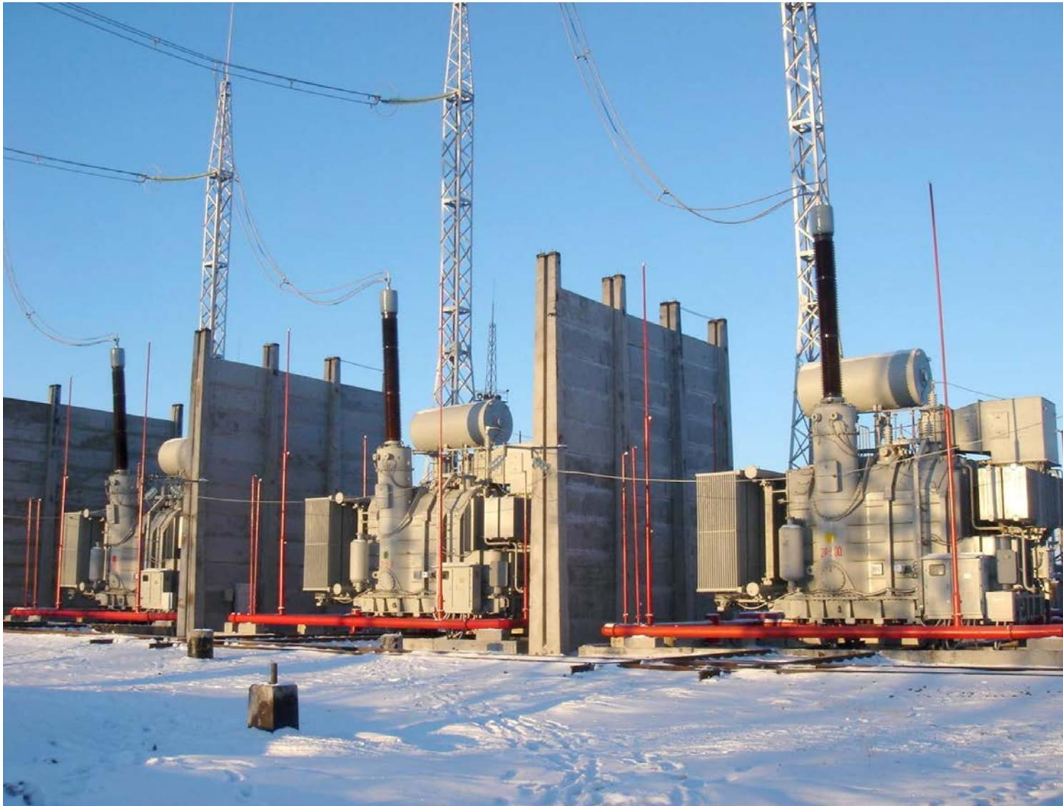
*Três MCSRs monofásicos 60 Mvar 500 kV para FGC UES SS «Tavricheskaya» (Rússia)*
