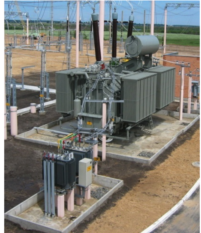
MCSR de 180 MVar 330 kV para Belenergo SE «Baránovitchy» (Bielorússia)
